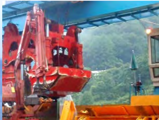
Video of Actual Dredging
